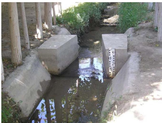
Рис.2. Водомерный лоток САНИИРИ (Ярцева). Вид с верхнего бьефа.
