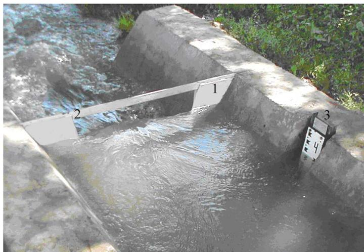
Рис. 1. Водослив Чиполетти (вид с верхнего бьефа) с уровнемерной рейкой в успокоительной нише
