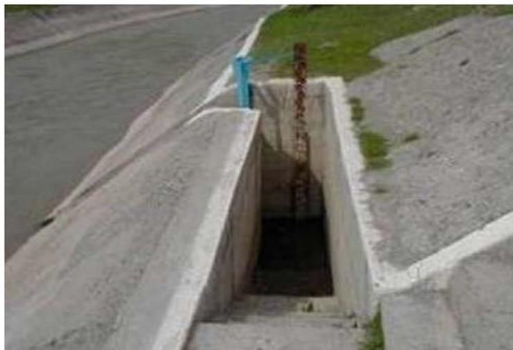
Рис.4. Успокоительный колодец с уровня мерной рейкой на гидрометрическом посту магистрального канала.
